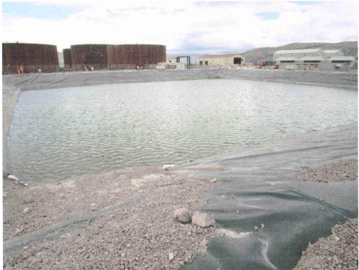
New Sewage Effluent Pond
